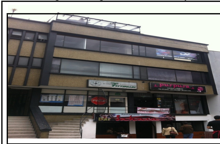
Fotografía No. 1: Fachada Peluquerias Purpura, Estética y Belleza ubicado en la Carrera 15 No. 73-66 Local 102.
